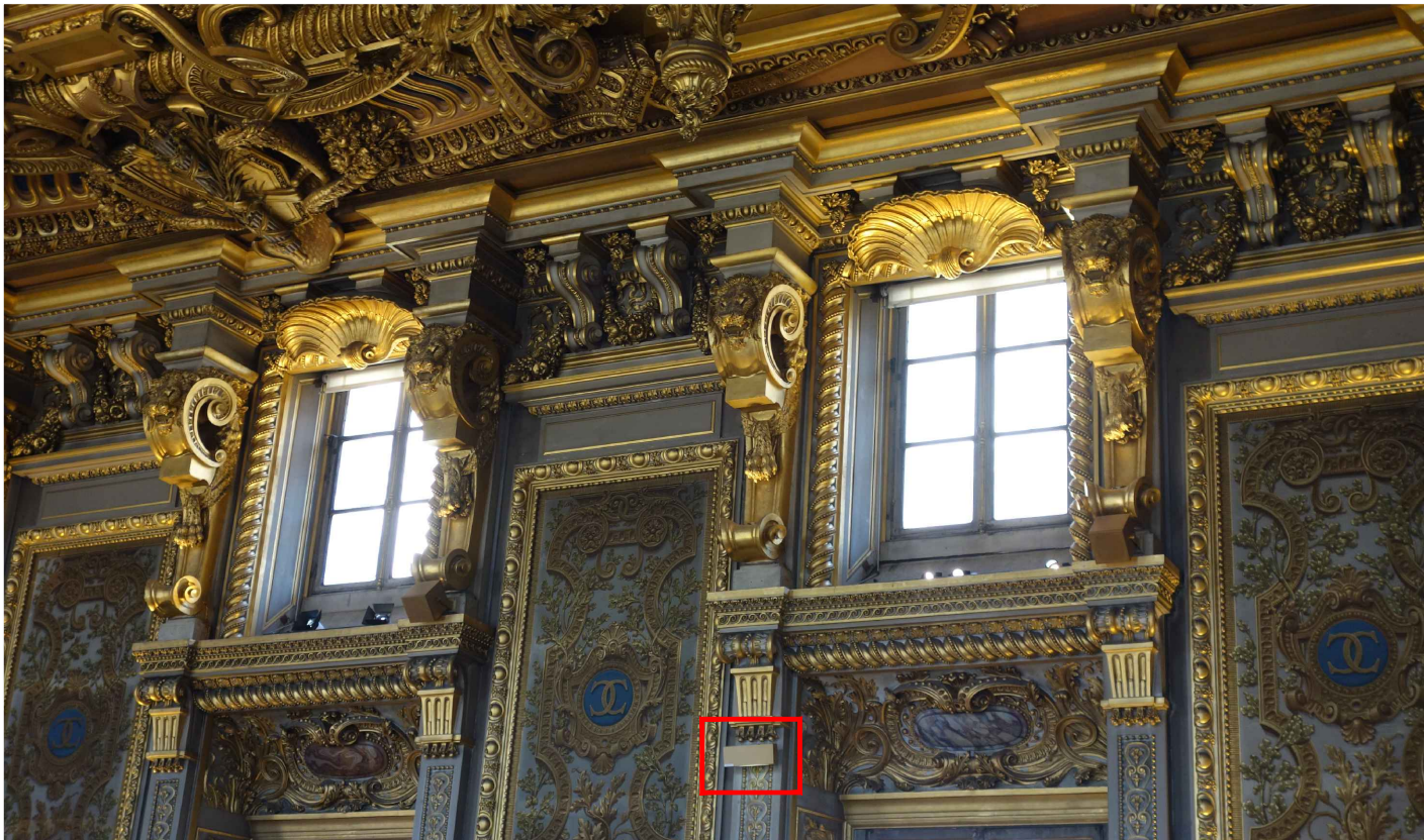
4 - Bloc d'ambiance existant à remplacer, alimentation à retrouver selon cheminement de câbles existants
