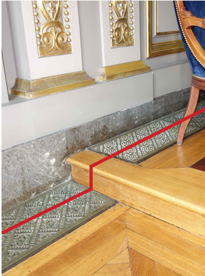
Niveau 1. Grand' Chambre, dépose-repose des grilles en laiton pour passage des câbles.
