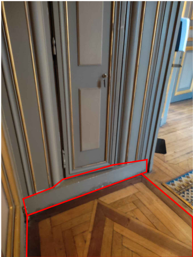
Dépose du parquet et plinthe devant l'armoire de commande
