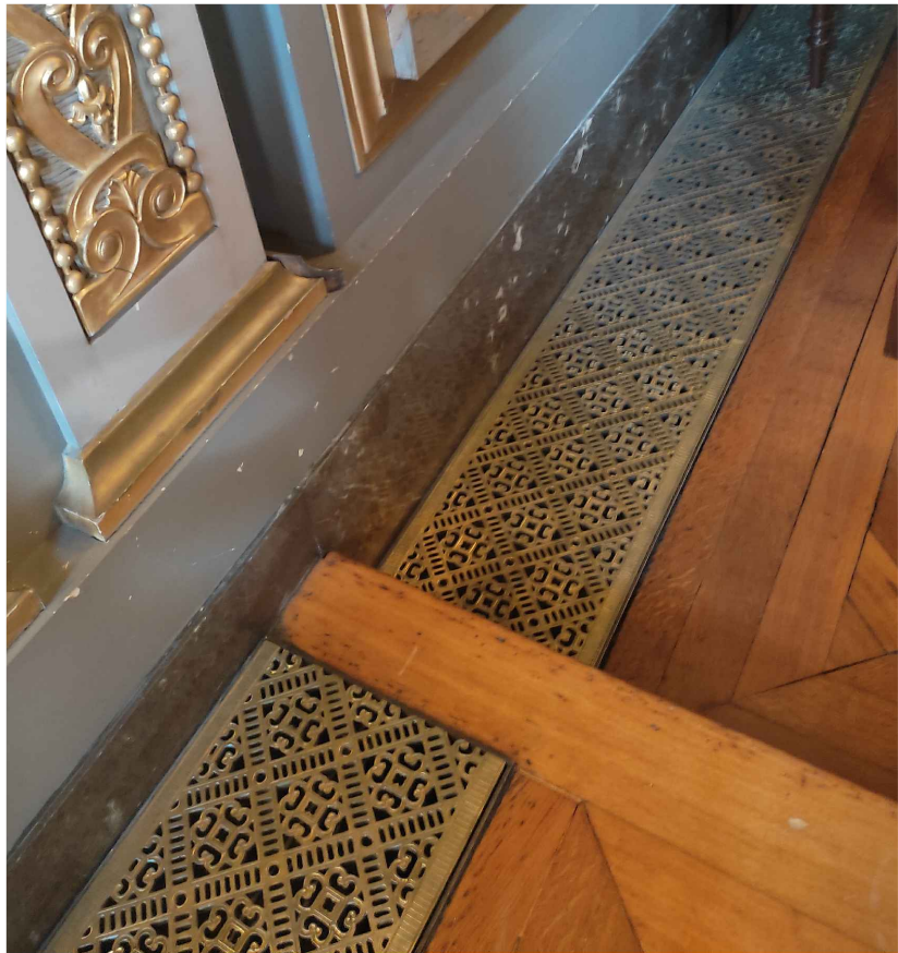
Dépose-repose des grilles de sol pour alimentation des équipements neufs par le caniveau existant
